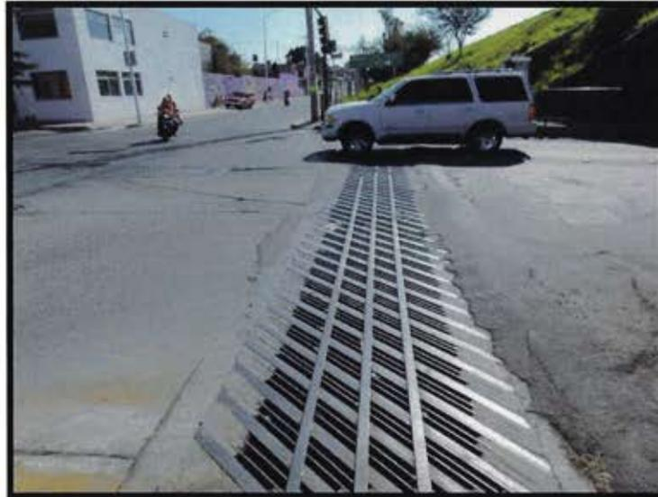
**Figuras 92 y 93. Bocas de tormenta con desembocadura hacia el Arroyo Huisquilco sobre la calle de Reforma. Fuente: Propia.**
