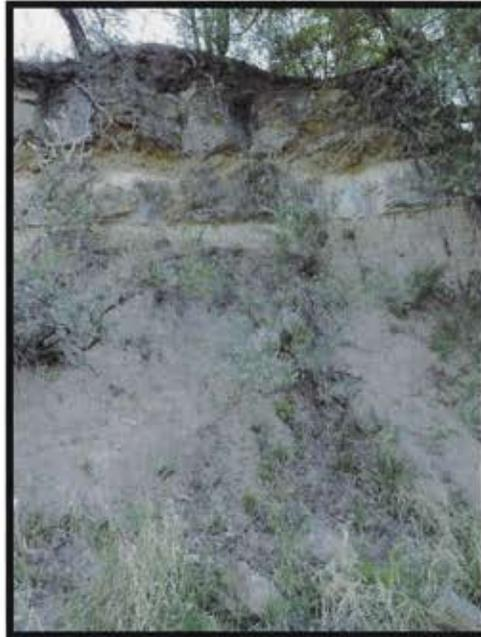
**Figura 67. Se muestra la fragilidad de la roca y la escasa vegetación que es muy propensa a caer sobre el camino.**
