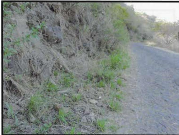
**Figura 70. Zona señalada como peligro por caída. Observase en la parte superior derecha la inclinación de la vegetación, indicando la inestabilidad de la pendiente.**
