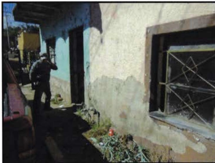
**Figura 111. 1.85 cm. de nivel aproximado de la inundación dentro de la casa con caída de piso por reblandecimiento consecuencia de que en los cimientos de la casa habitación pasa el cauce del arroyo (Localidad Santa Fe). Fuente: Propia.**
