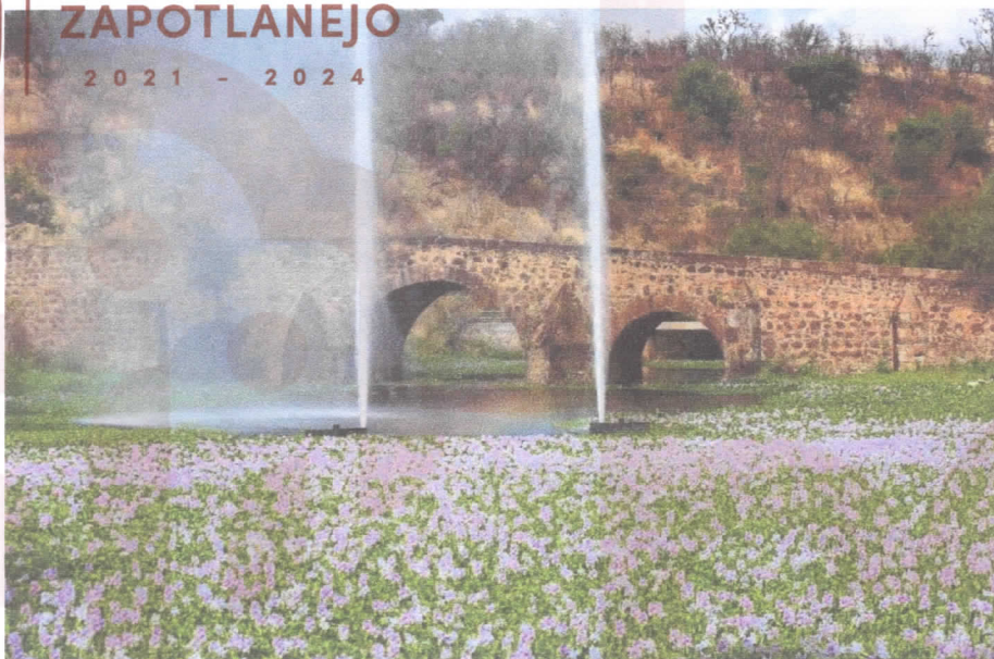
PUENTE DE CALDERON
